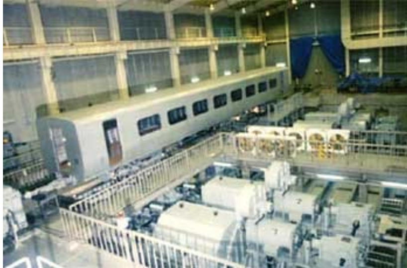
รูปที่ 7 Rolling stock test plant
